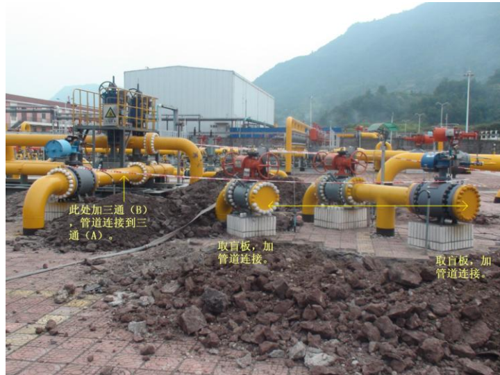
达州普光首站现场改造图
